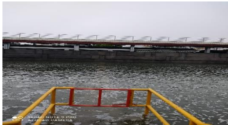
Rain water Storage – 900 kL
